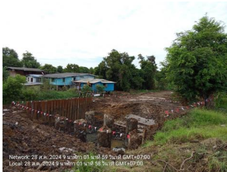
ภาพที่ 2.2-45 การติดตั้ง Sheet Pile
