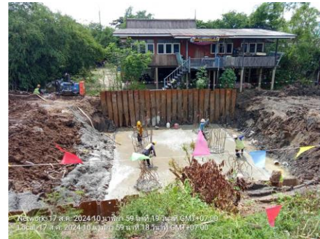
ภาพที่ 2.2-45 การติดตั้ง Sheet Pile
